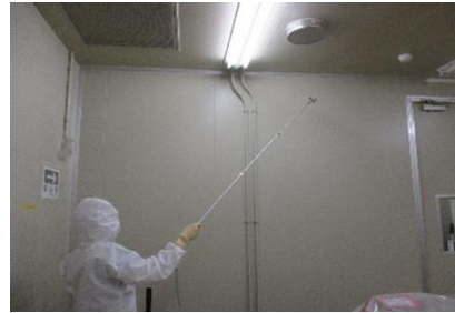
クリーンルーム内 除染役務の様子
